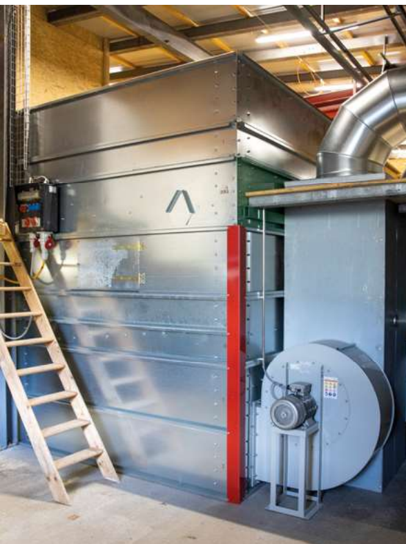
Ein Lüfter bläst auf 25 Grad erwärmte Luft zwischen den Walnüssen hindurch.
